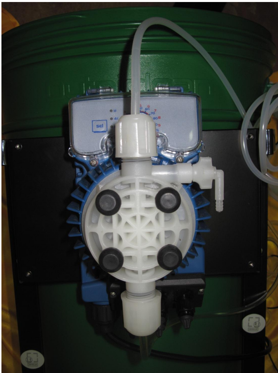
Рисунок 7-6 Установка насоса на панель управления
